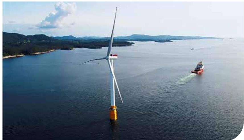
Eine schwimmende Windkraftanlage wird aufs Meer geschleppt
