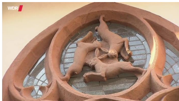
Hasenfenster am Paderborner Dom
