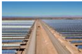
Solarrinnenkraftwerk
